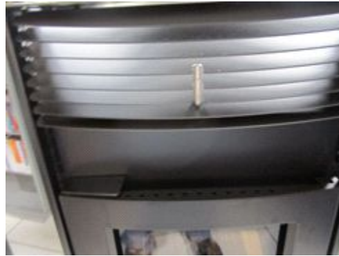
Sortie d'air chaud ambiant et tige du racleur permettant de nettoyer l'échangeur des suies
